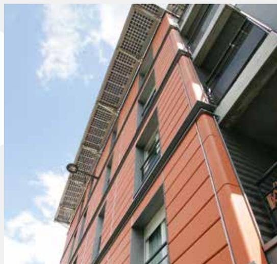
188 m<sup>2</sup> de cellules photovoltaïques sont intégrées sur l'immeuble de la rue Moyrand à Grenoble, pour l'électricité des communs.
